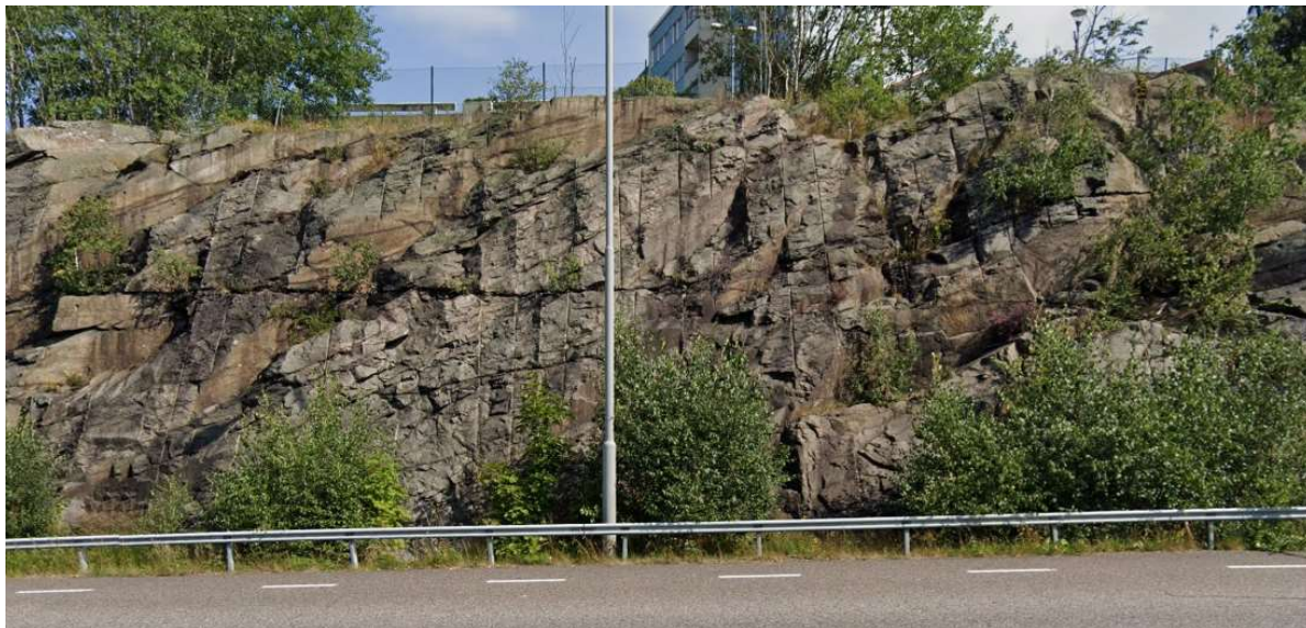
Figur 8B Bergsskärning mot Bergsjövägen söder om södra plangränsen. Deltaljplanegränsen går vid staketet strax norr om bergskrönet. Vy mot norr.
